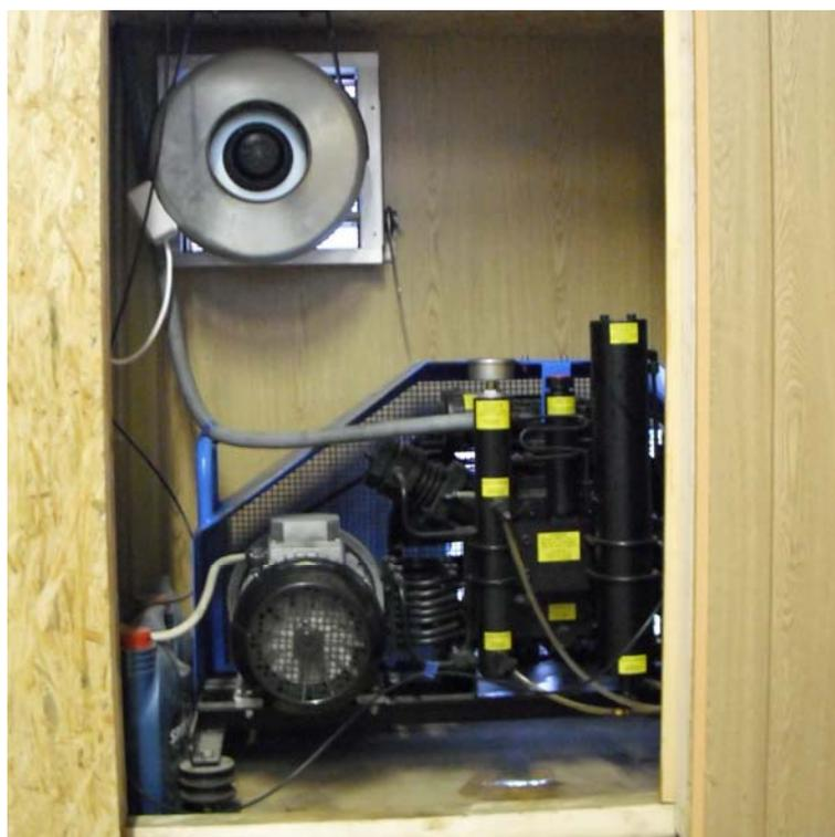
**Фото 4. Электрический компрессор ВВД Coltri Sub MCH-16ET Standard 265 л/мин 225 бар с системой отсчета времени работы и дистанционного управления**
