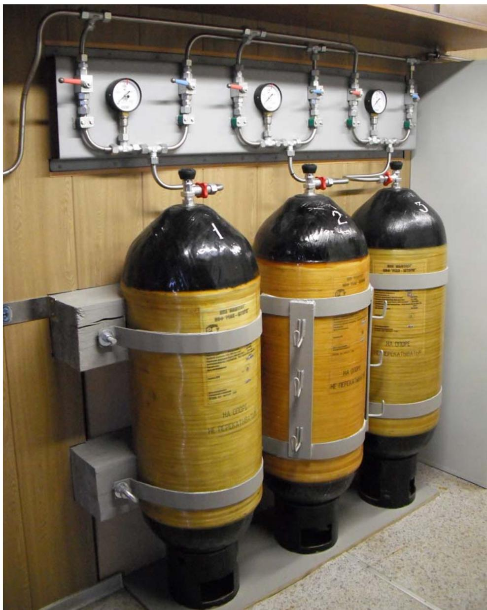
**Фото 5. Сборно-разборный воздухораспределительный пульт из нержавеющей материалов  $P_{\text{раб}}=400$  бар с металлокомпозитными баллонами-воздухохранилищами  $V=100$  л  $P_{\text{раб}}=330$  бар**
